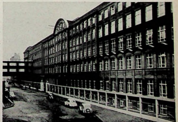
Das Wernerwerk 1 in Siemensstadt in seiner gegenwärtigen Form. Links der Übergang zum Wernerwerk-Hochbau
